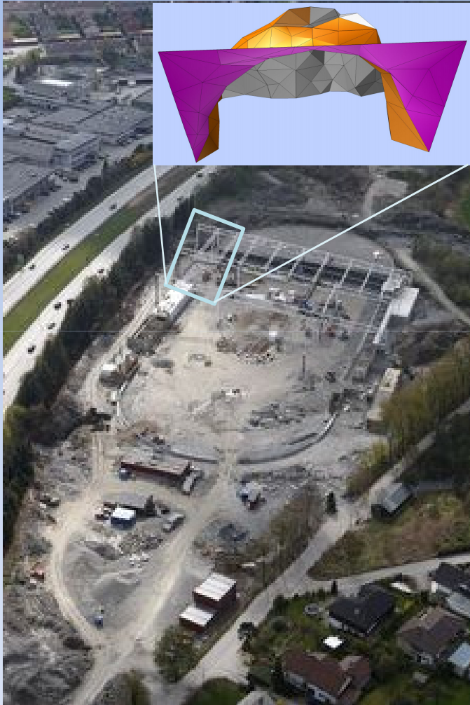
Oversiktsbilde av Sørmarkahallen under bygging.
